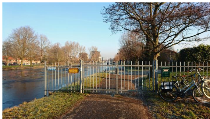
Als laatste: toegangshek op slot
